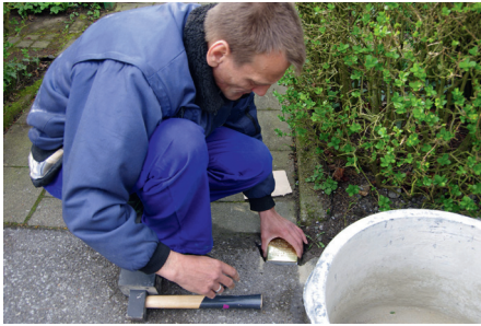
Die Verlegeaktion am 20. April 2012 begann in der Helmutstraße in Barmen.
